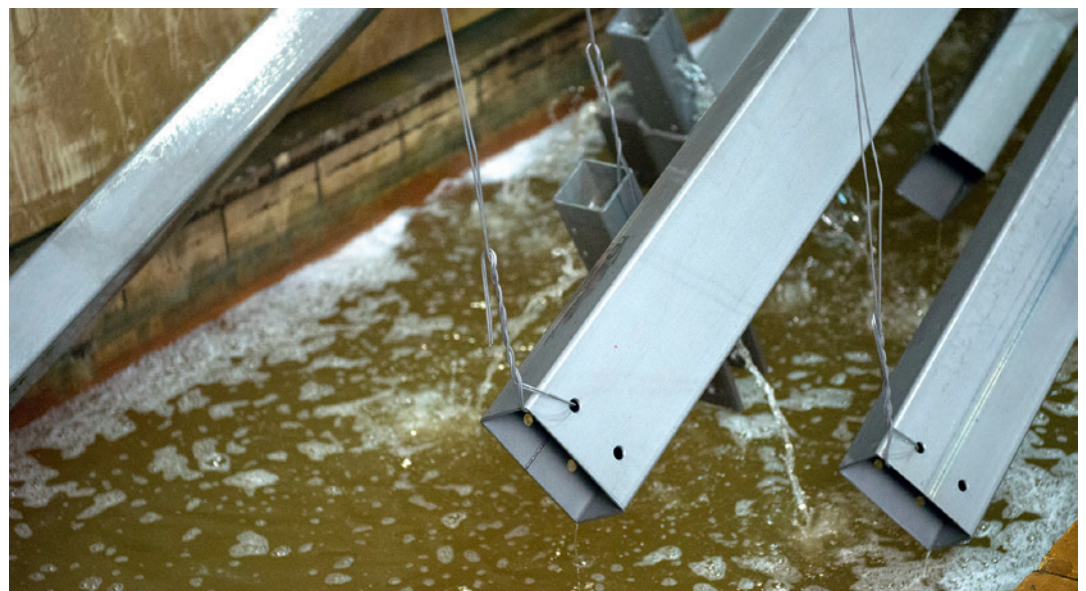
Das Vorbehandlungsbecken stellt eine HBV-Anlage laut AwSV dar.
